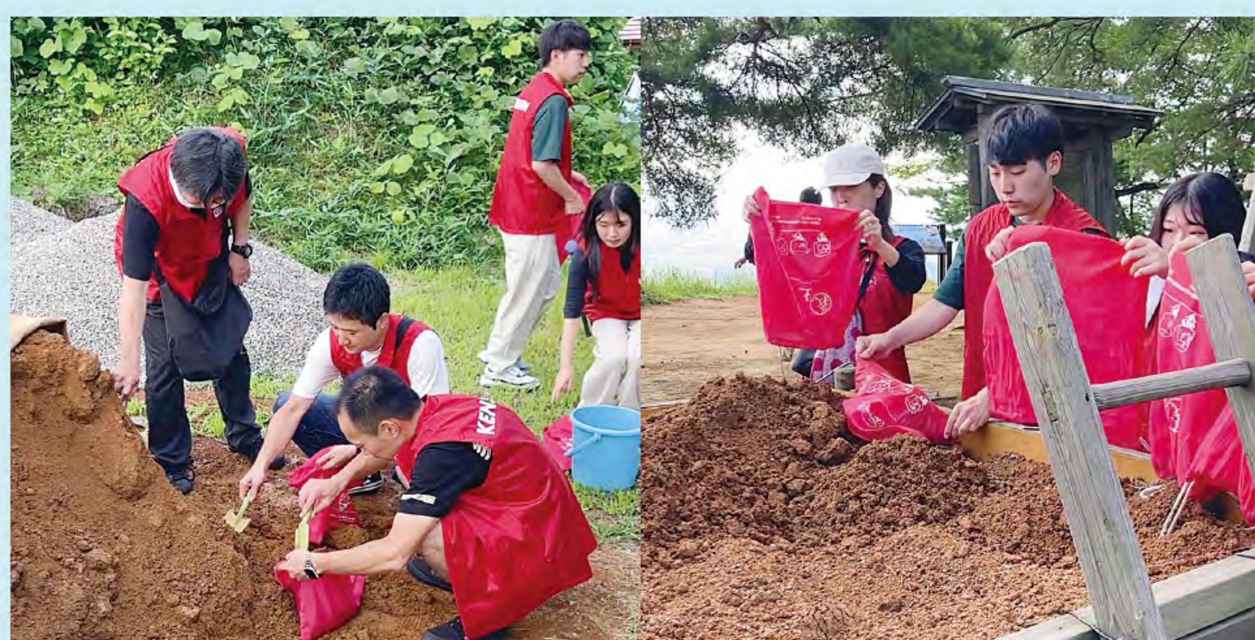
一生懸命運んだ土を皆で広げています
