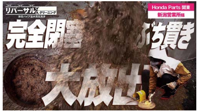
▲迫力の施工風景！
